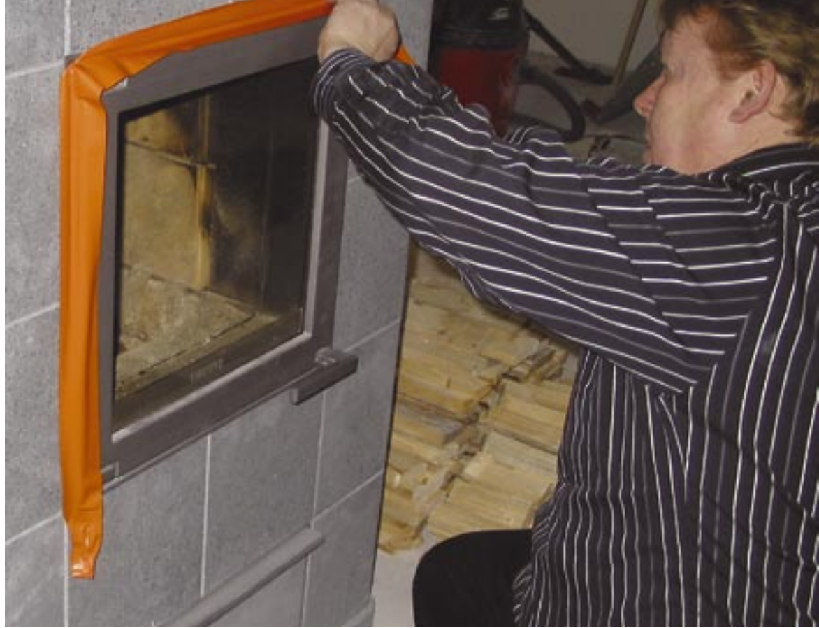
Mittauksen ajaksi mm. ilmanvaihtohormit ja tulisijan suuluukkujen saumat teipataan tiiviiksi.
