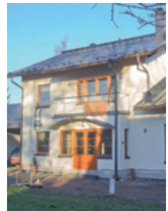
Tämä Jämerä-matalaenergiatalo on rakennettu Siporex-kevytbetoniharkoista.
