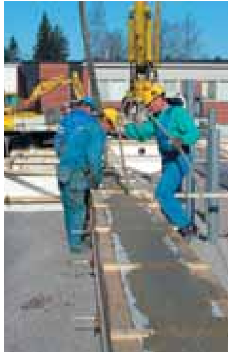
Valu sujuu pumppuautolla nopeasti. Valun yläpinta hierretään lopuksi tasaiseksi.
