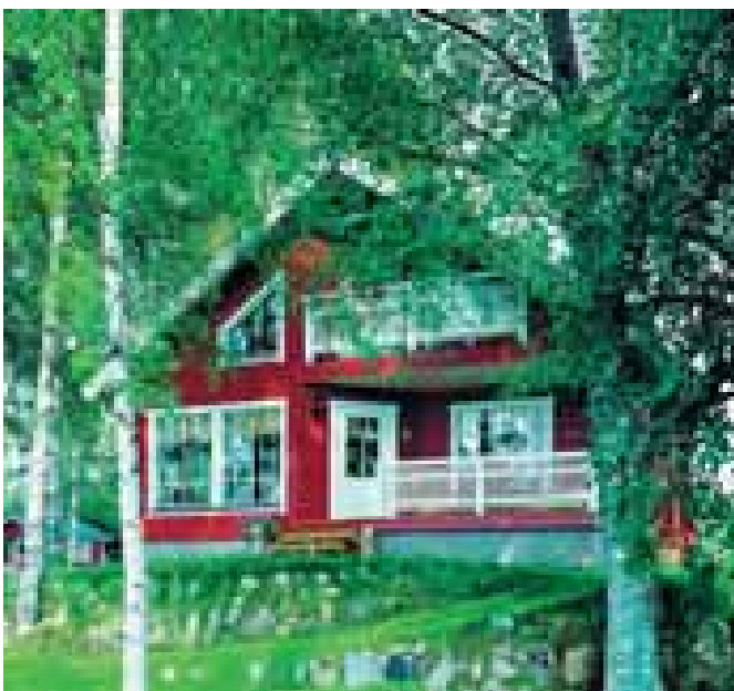
Lämpöhirsirakenne sallii persoonalliset vinot ikkunat ja seinälinjat painumattomuutensa ansiosta. Kuvassa Lapponia Housen Pinea 76 -malli.
