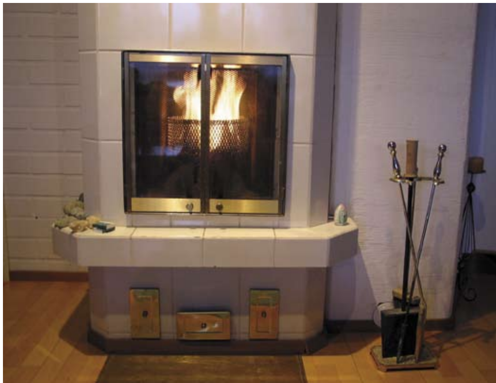
Pelletti palaa suhteellisen pienellä liekillä kunnes noin puolet määrästä on palanut. Tämän jälkeen hiillos on erittäin kuuma. Pelletillä saa mietoa, tasaista lämpöä pitkän ajan, puilla suuren määrän lämpöä nopeasti.
